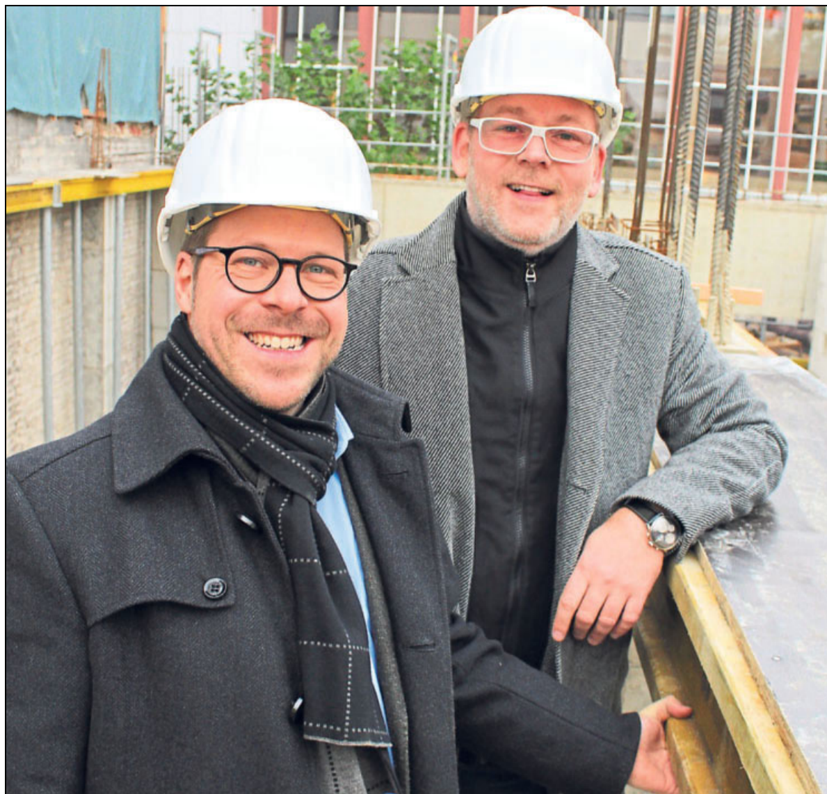
Henrik Krömker, Inhaber des Hotels Hansa (links), und Architekt Ralf Cziesla auf der Baustelle zwischen Martinsgang und Brüderstraße. Bis Februar soll der Rohbau stehen. Foto: Ralf Meistes
